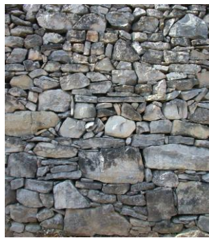
Mur en pierres sèches
